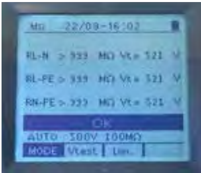
Isolationsmessung gegen alle Leiter L-N-PE
