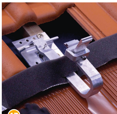
17 Einschnitt des Schaumstoffkeils um den Dachhaken stülpen.
