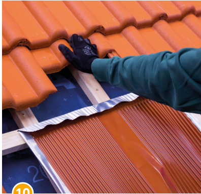
10 Dacheindeckung über Beta-Platte aufdecken.
