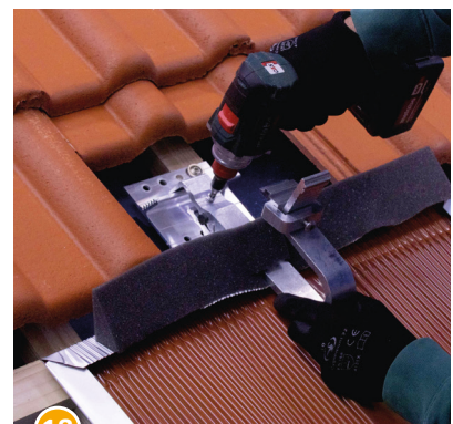
18 Position des Dachhakens durch Anziehen der Schraube fixieren (6 Nm).
