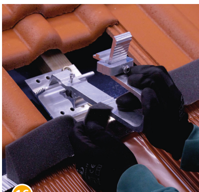
16 Dachhaken in Fuß einhängen.
