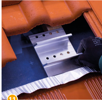
11 Fuß des Dachhakens auf dem Dachsparren ausrichten.
