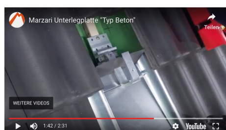
Montage der Metaldachplatte „Typ Beton“
