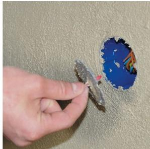
Putzfeder entfernen und mithilfe des Zentrierbohrlochs Dosendeckel ausfräsen.
