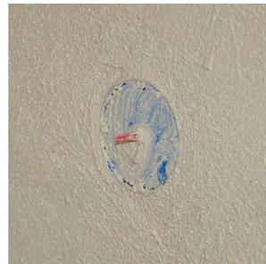
Der Putzer drückt beim Verputzen den Deckel auf die benötigte Höhe - garantiert putzbündig und VDE konform!
