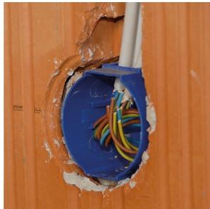
Unterteil bündig setzen, Kabel oder Rohre einführen.
