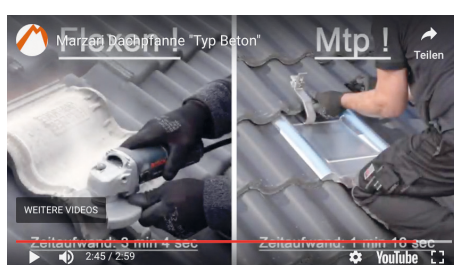
Zeitersparnis durch Einbau unserer Metaldachplatte
