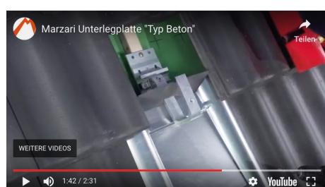
Montage der Metaldachplatte „Typ Beton“
