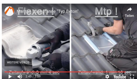
Zeitersparnis durch Einbau unserer Metaldachplatte
