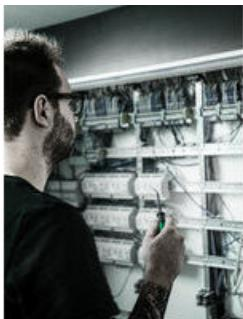
Aufgrund der gebogenen Geometrie können auch Reihenklemmen betätigt werden, die man mit einem normalen Schraubendreher nicht erreicht
