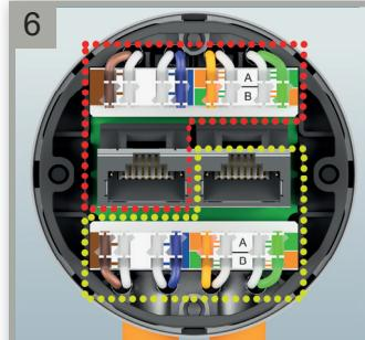
Obere Adern werden zur linken Buchse geführt, untere Adern werden zu rechten Buchse geführt.
