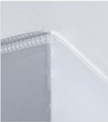
Verlegung des Clear Track- Glasfaserkanals für den Flurbereich um eine Außenecke
