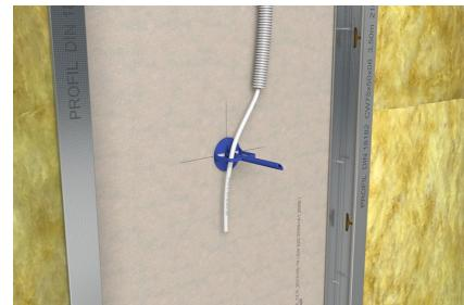
Leitungsträger auf Trockenwand befestigen und Leitungen oder Rohre durch Bügel führen.
