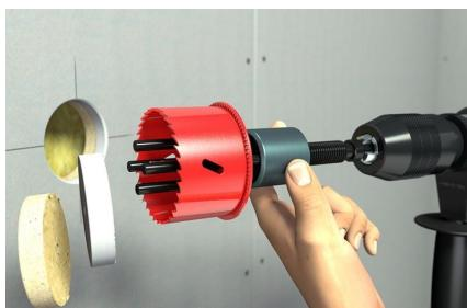
Dosenfräser im Zentrierbohrloch ansetzen und Loch ausfräsen.
