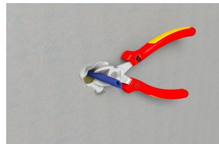
Leitungsträger mit Zange bündig zur Wand abwickeln.
