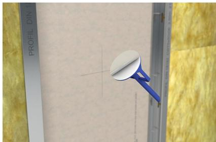
Klebescheibe auf Leitungsträger kleben und Schutzfolie abziehen.
