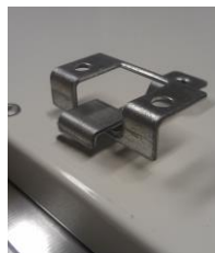
Detail eingehängte Deckenhalter
