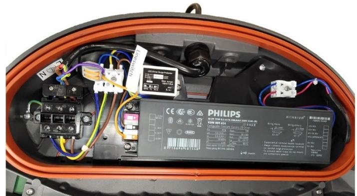
Abb. 5: Anschlussraum mit Anschlussleitung
